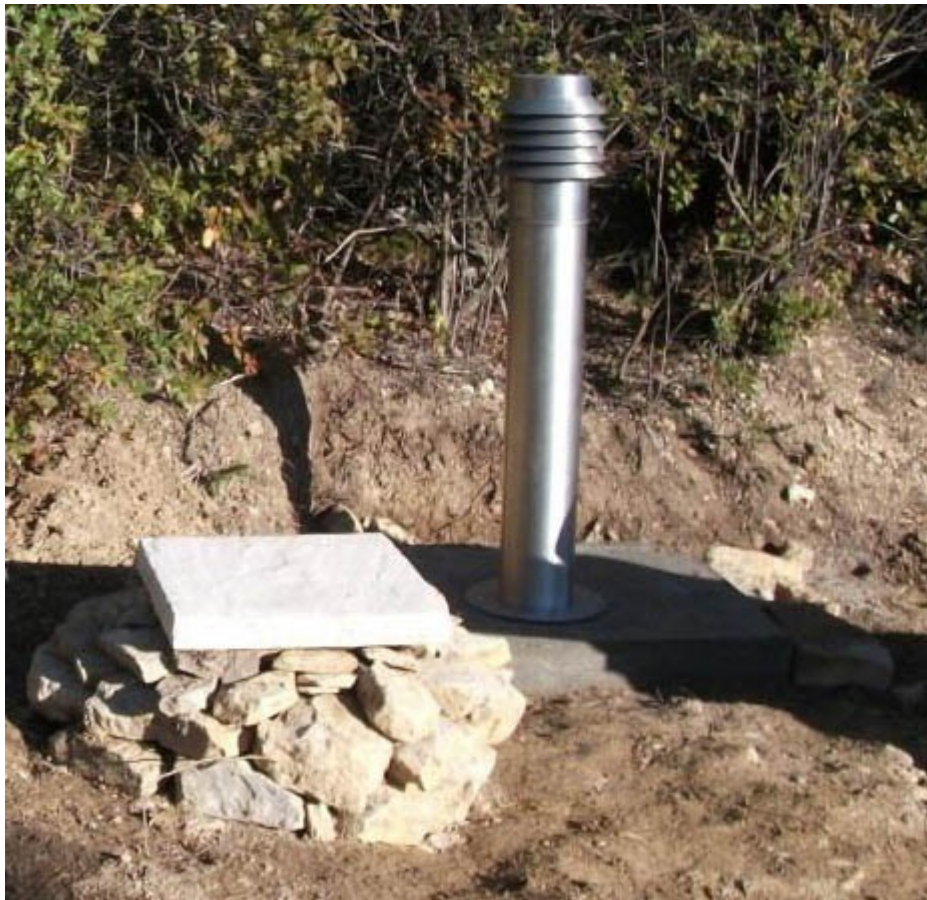
Cheminée de départ en inox avec son filtre G4, vissée sur son socle en béton
