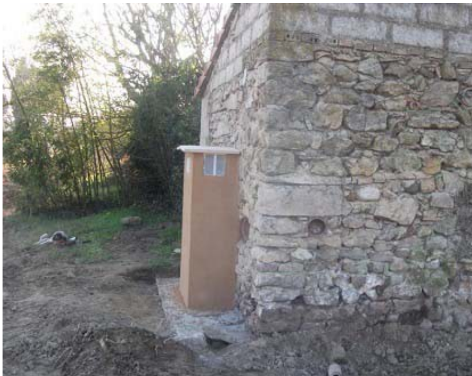
Cheminée de départ en boisseaux (25 x 50 cm) pour un double puits, adossée à un mur
